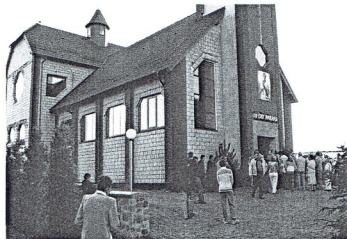
Fot. Ryszard Gruszkiewicz Kościół błogosławionej Anieli Salawy w budowie
