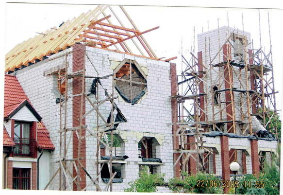
Dokończanie konstrukcji dachu nad prezbiterium. 22.06.2005.
