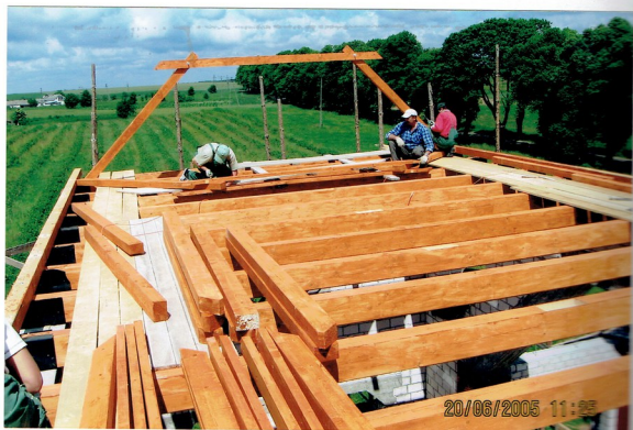
Wykomanie konstrukcji dachu nad prezbiterium 20.06.2005
