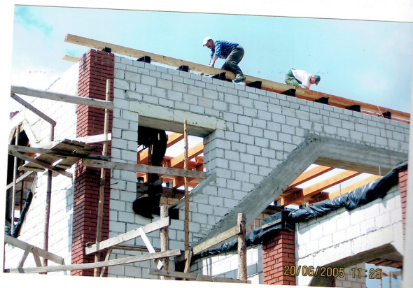
Wykomanie konstrukcji dachu nad prezbiterium 20.06.2005
