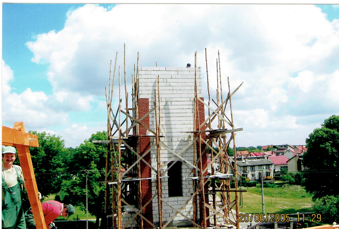
Przygotowanie wieży pod przemieszczenie dzwonu.
