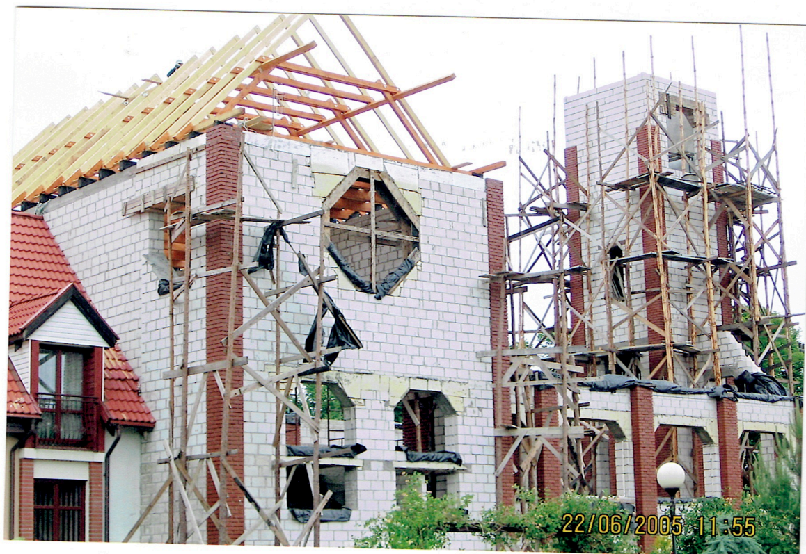
Dokończenie konstrukcji dachu nad prezbiterium. 22.06.2005.
