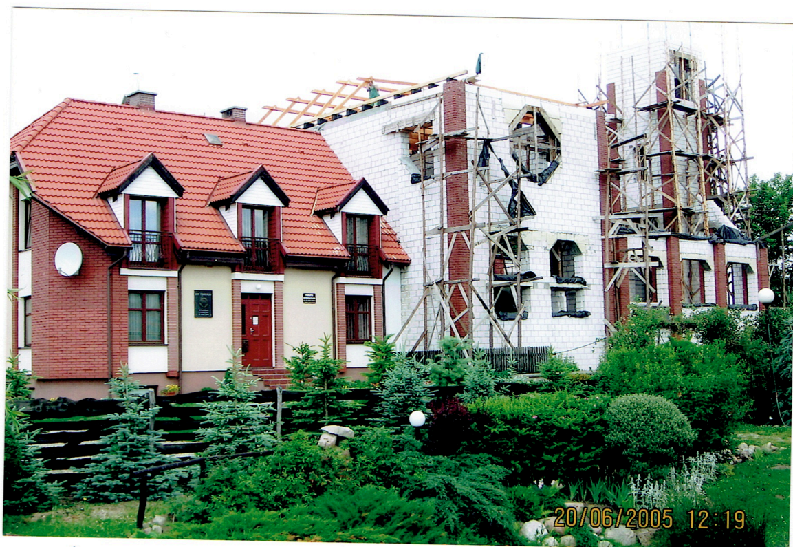
"Rzut" na budowę od strony ogrodu. Wykonanie konstrukcji dachu nad prezbiterium.
