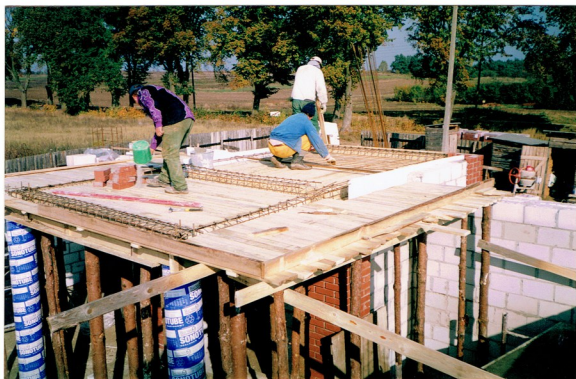
strop na mietzy i nad wejściem
