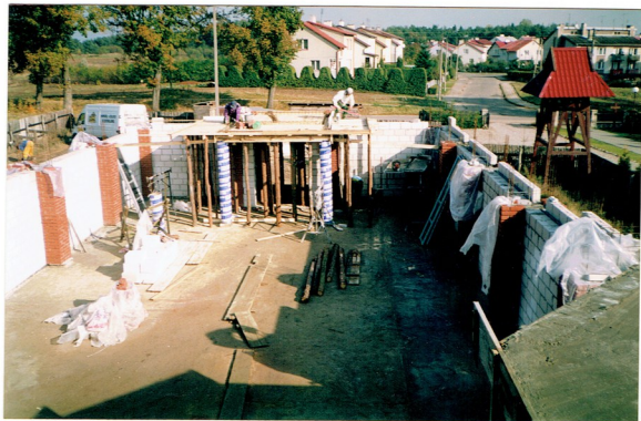
wykomanie stropu nad wejściem
