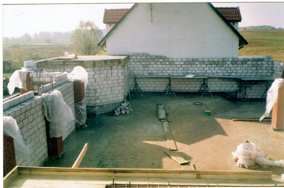
Wykonamy strop nad zakrytą
