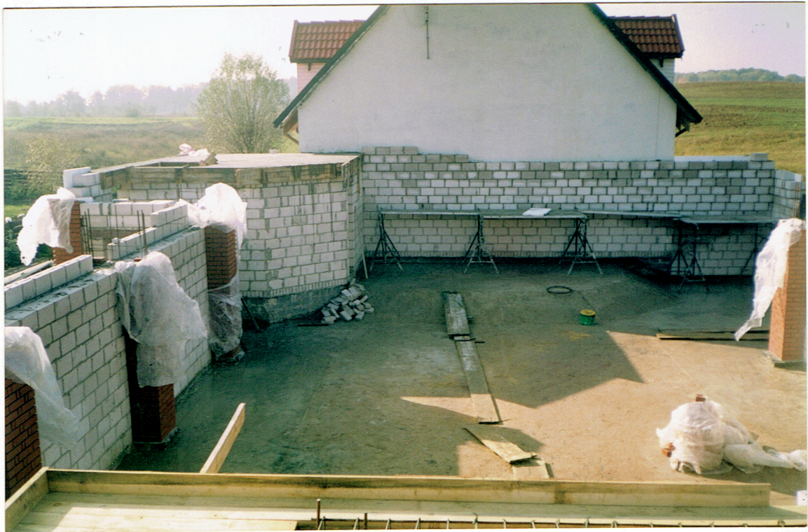
wykonujemy strop nad zakrystią
