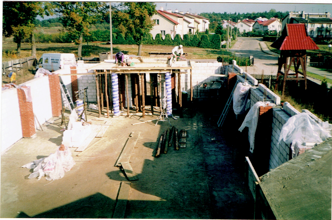
wykonanie stropu nad wejściem
