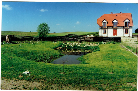
Zdjęcie z wiosny 2000. Stąd budowy wczesną wiosną.
