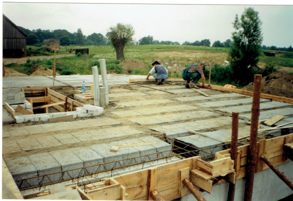
Prace związane z budową stropu piwnicy.
