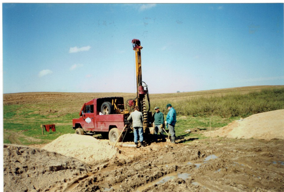
20-25.04.1998 - Umocnienie gruntu pod budowę.
