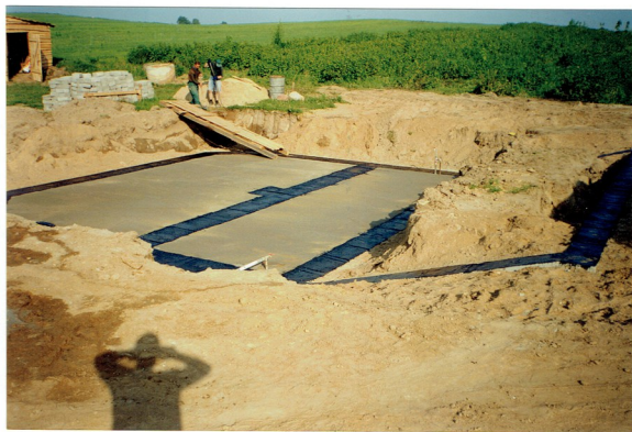
stan prac budowlanych z końcem maja 1998 roku
