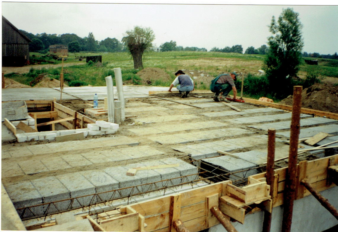
Prace związane z budową stropu piwnicy.
