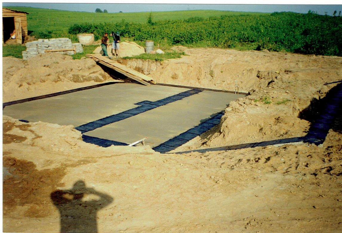
Stan prac budowlanych z końcem maja 1998 roku
