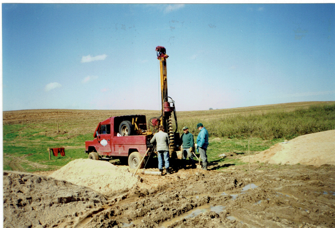
20-25.04.1998 - Umocnienie gruntu pod budowę.
