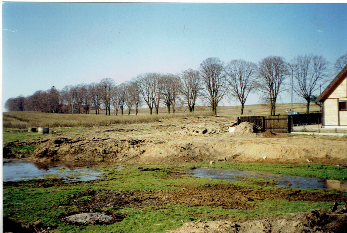
plac budowy - - tu za kilka miesięcy powstanie dom parafialny.
