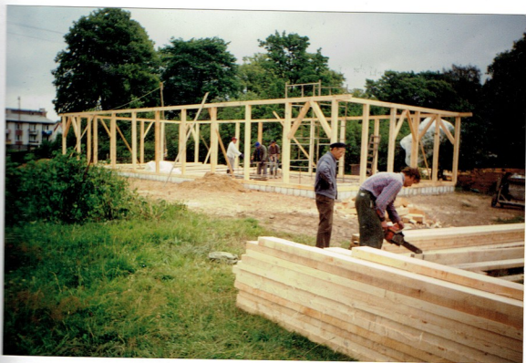
Konstrukcja ścian już gotowa.
