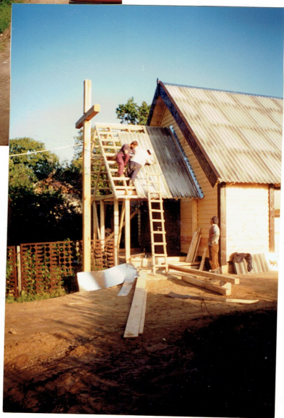
Budowa przedniotka kaplicy w zmniejszonym sktadzie (Olek i Marek wyjechali na kilka dni do Limanowej)
