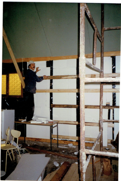
Ocieplanie ścian kaplicy i wykańczanie wnętrza.
