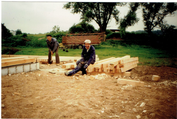
Przygotowywanie konstrukcji drewnianej
