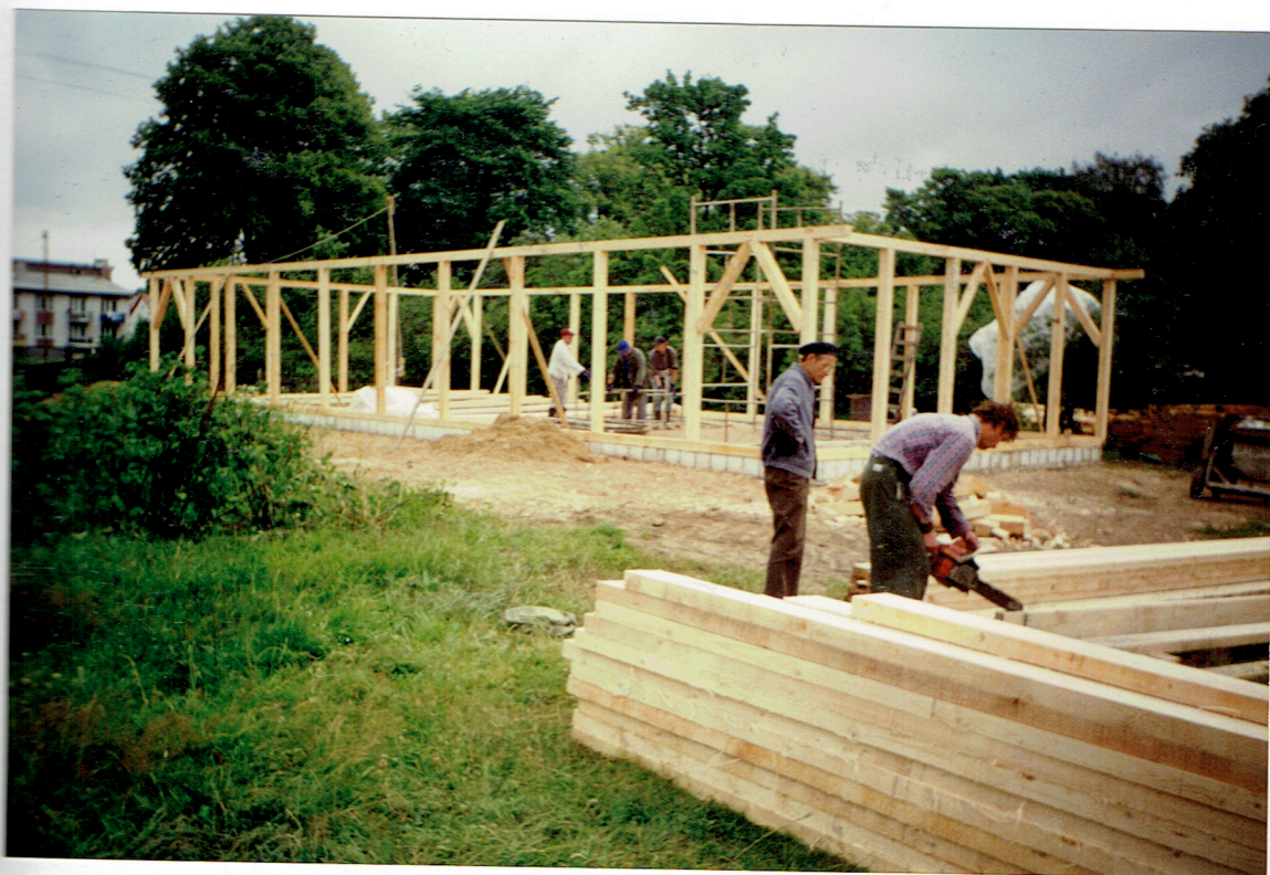
Konstrukcja ścian już gotowa.
