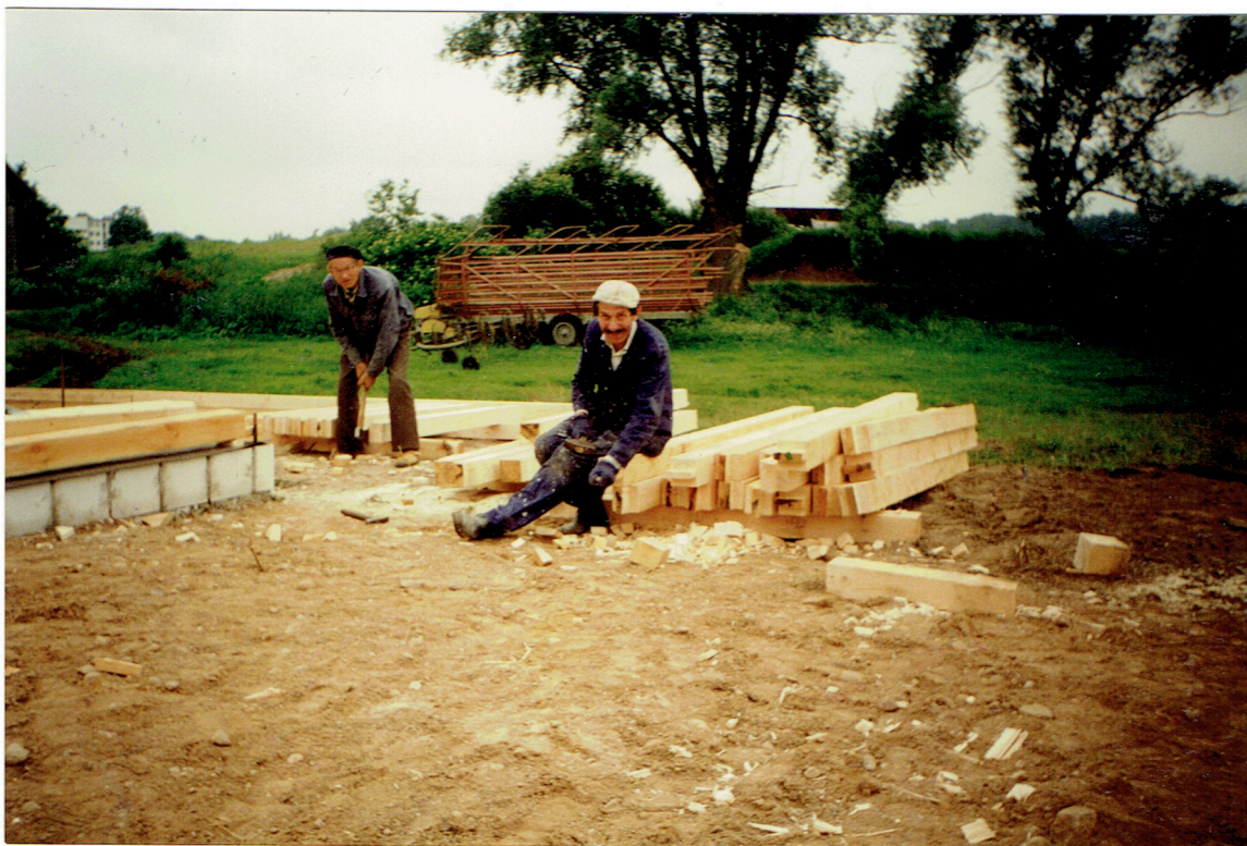
Przygotowywanie konstrukcji drewnianej
