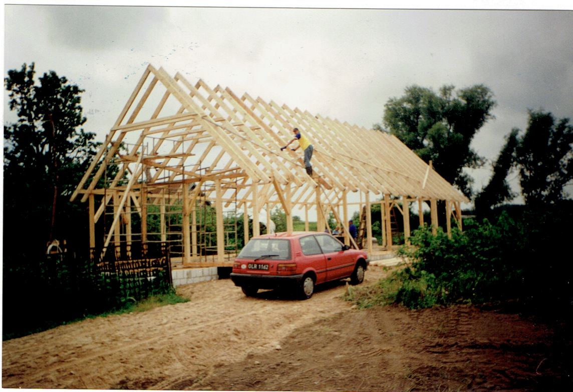
Widoczny wanyk, to pierwsza droga, którą można dojść albo dojechać z ul. Wilczej do przyszłej kaplicy.
