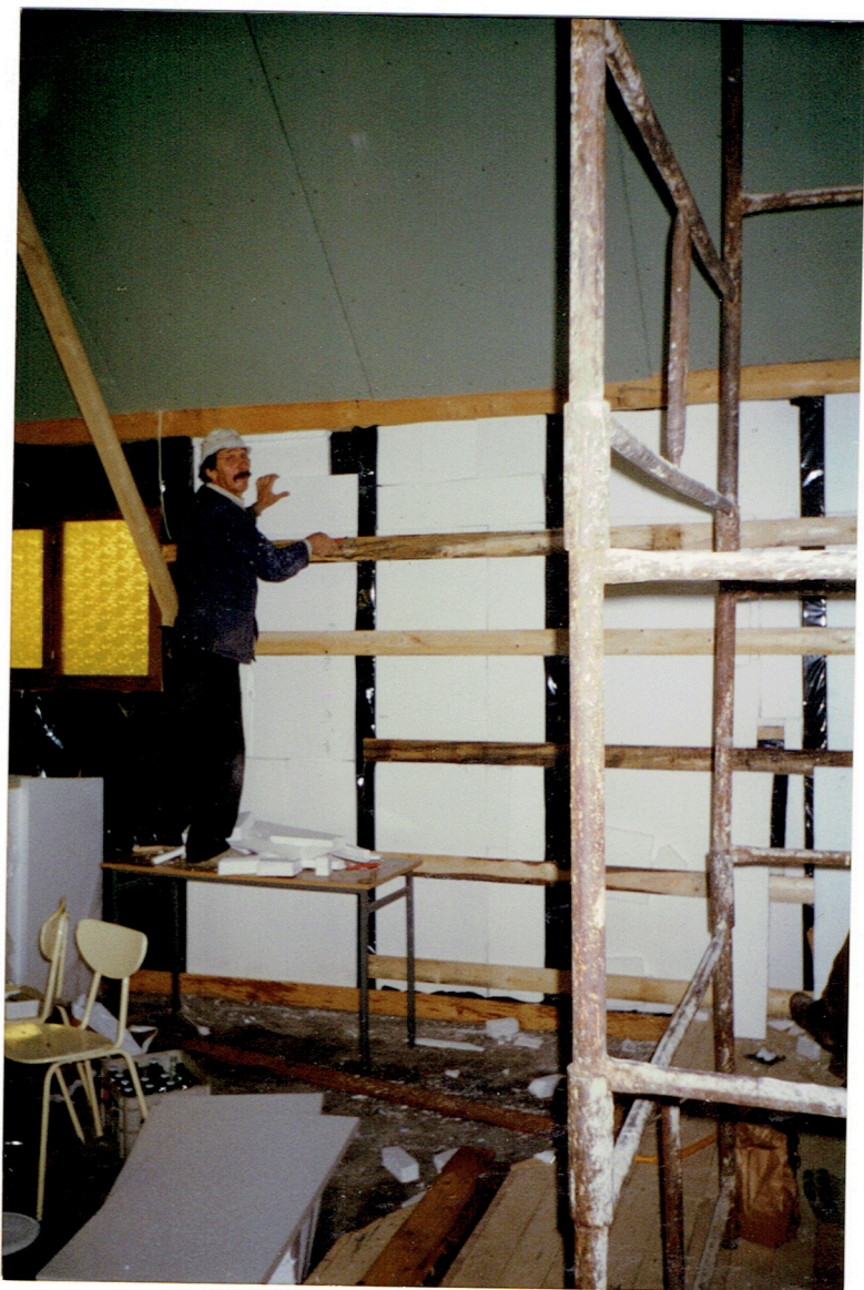
Ocieplanie ścian kaplicy i wykańczanie wnętrza.
